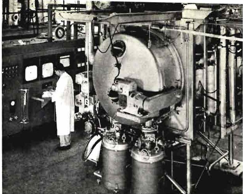
Distribuidor al vacío de leche para ser transformada en leche entera desecada. (Fot. U. S. D. A.)
