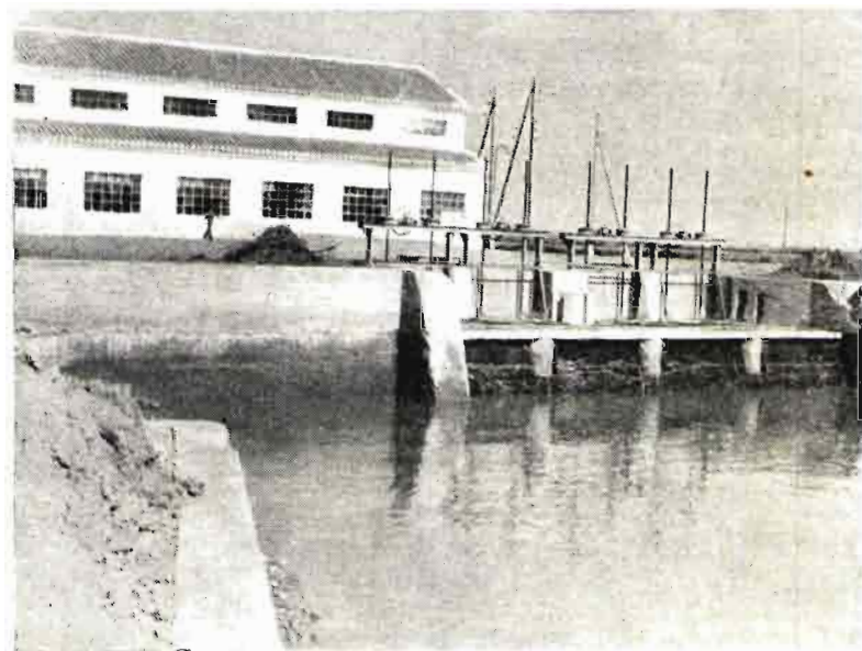
Vista parcial desde el exterior de la misma instalación. En el cálculo del agua a elevar hay que tener en cuenta la salinidad del agua o del suelo y prever el exceso de agua de drenaje y lavado. (Foto Blasco.)
