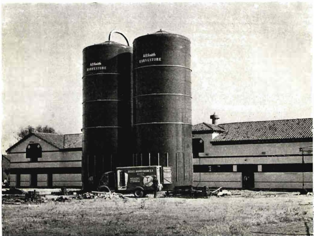
Con el montaje de dos «Harvestores» de 405 m. 3 , en junio de 1962, en la explotación agropecuaria ejemplar «Bascones del Agua», en Lerma (Burgos), empieza la nueva zootecnia Industrial Harvestore en España. Se utilizan para la conservación de alfalfa con el 40 al 50 por 100 de humedad.
