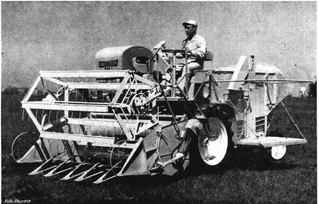
Desde el asiento del conductor deben poder accionarse los mandos de la máquina con esfuerzo mínimo, permaneciendo siempre el operador aislado de las piezas en movimiento mediante las adecuadas protecciones.
