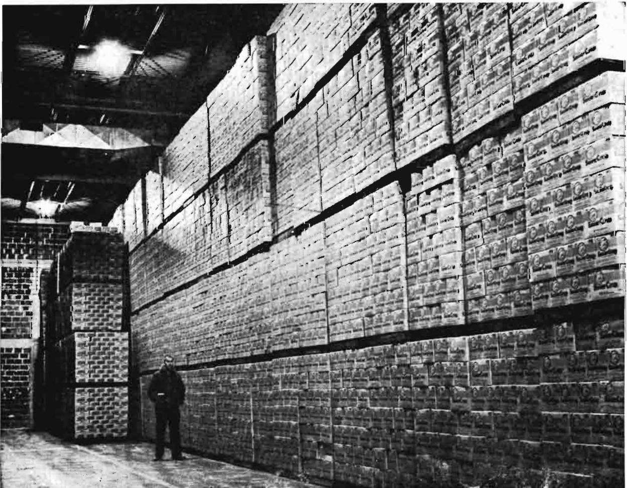
Almacenamiento bajo refrigeración: En este almacén se conserva a  $25^{\circ}$  C. bajo cero las latas de zumo concentrado, empaquetadas en envases de cartón. Tiene cabida para 7.5 millones de cajas.
