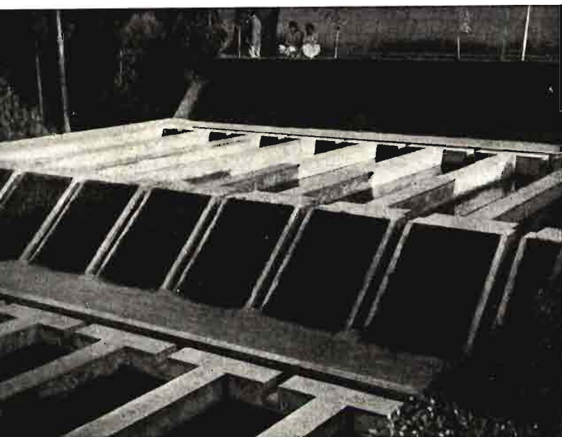
La doble batería de estanques longitudinales de recría, mostrando los canales de oxigenación.
