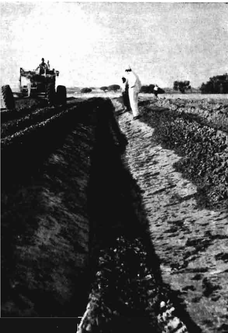
Preparación de un terraplén con motoniveladora.
