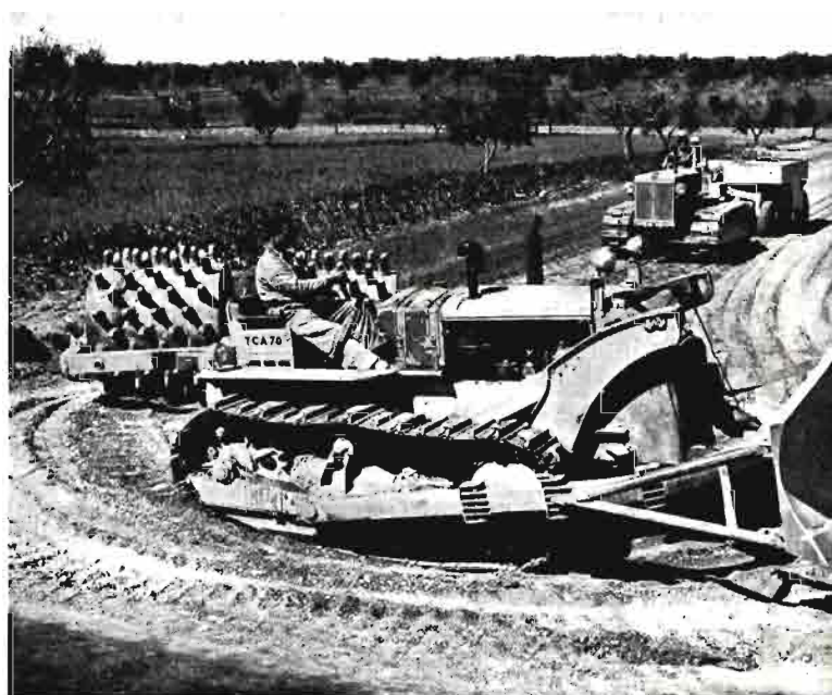
Compactando con cilindro y rodillo de pie de cabra.
