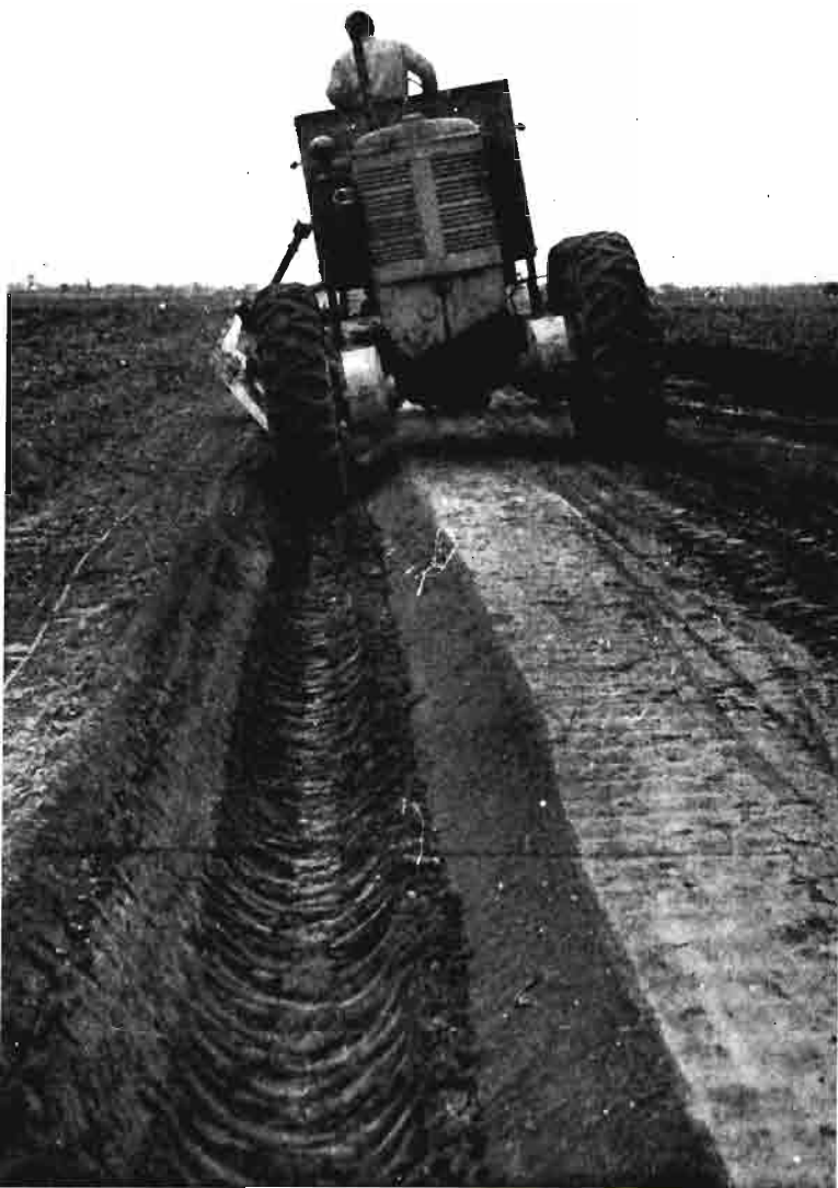
Construcción de cunetas.
