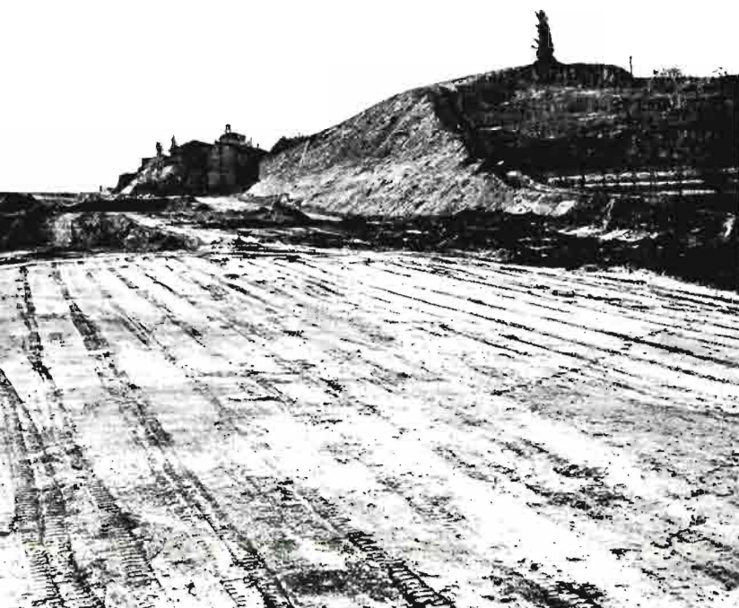
Primera fase de la compactación.
