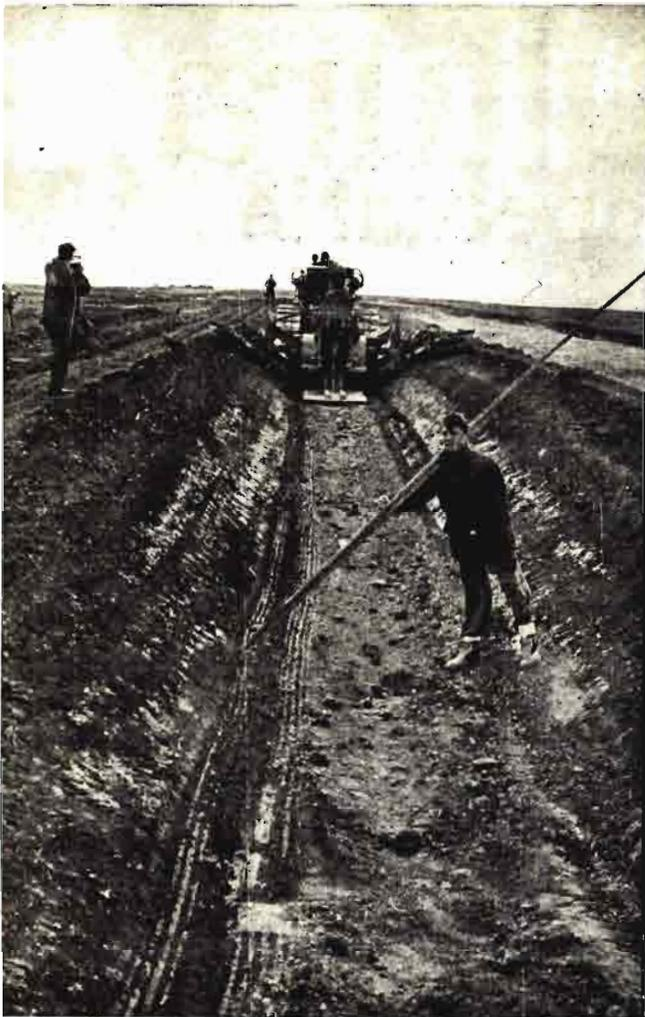
Poderoso abrezanjas, excavando y talizando simultáneamente la acequia XXX-4-2.
