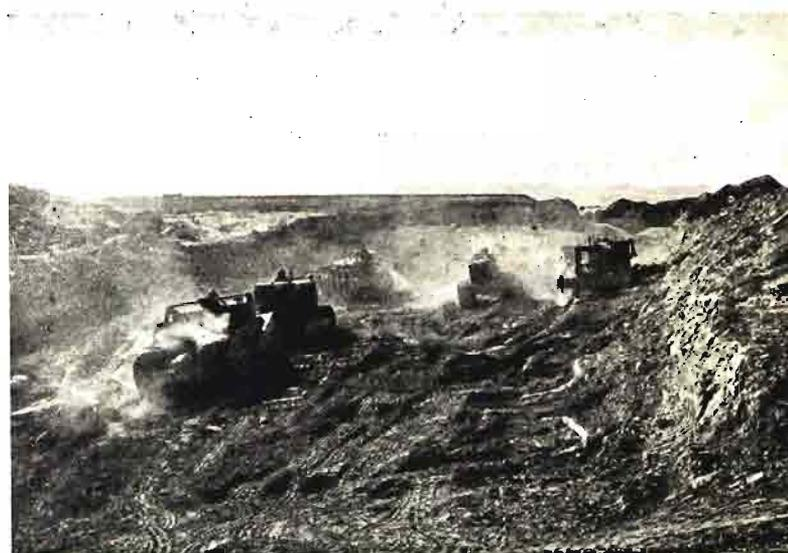
En ese infierno de polvo, los equipos trabajaron en apretado haz, constituido por un subsolador, una despedazadora y dos traillas pesadas.
