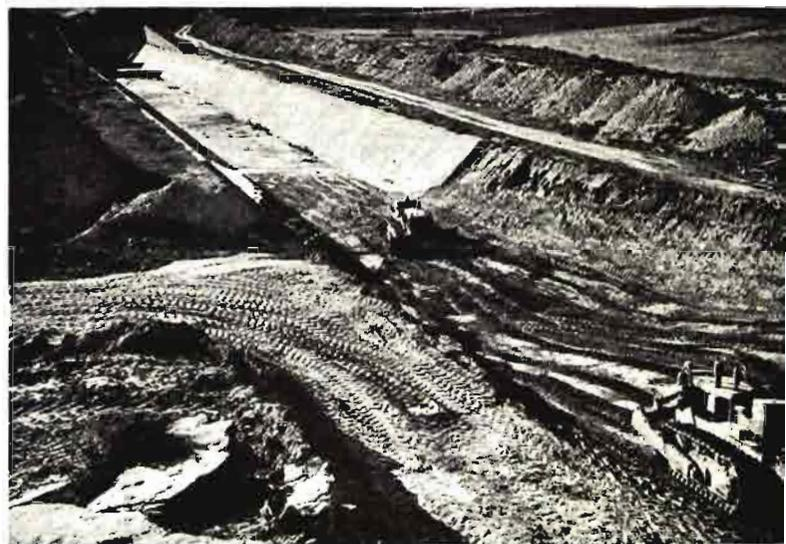
Inmediatamente de terminar la explanación se efectuó el revestimiento del canal.
