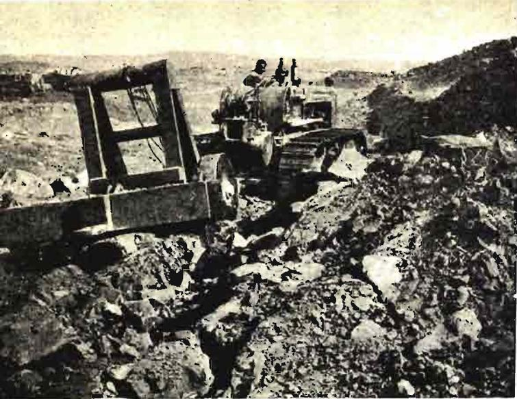
La dura labor de subsolado, realizada después de cada voladura, como operación previa imprescindible para la actuación de los equipos de carga y transporte.
