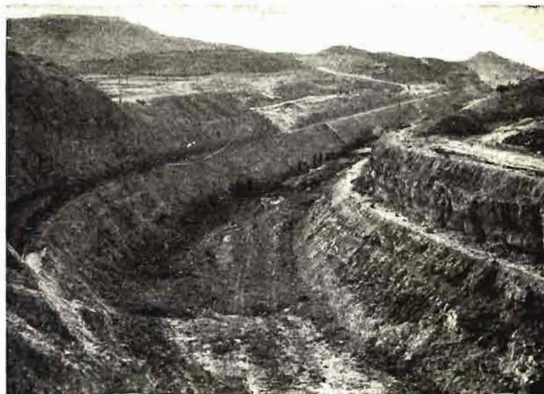
Con los equipos mecánicos utilizados se consiguió un «acabado» de los taludes que no requirió un gravoso refino a mano.
