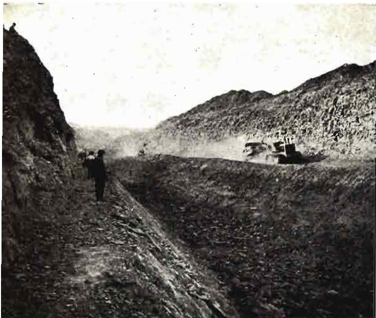
La eficacia de los equipos móviles de carga y transporte sobre las excavadoras se acentuó en aquellos tramos en que el volumen de la excavación por encima de la rasantes superior del canal era elevada.
