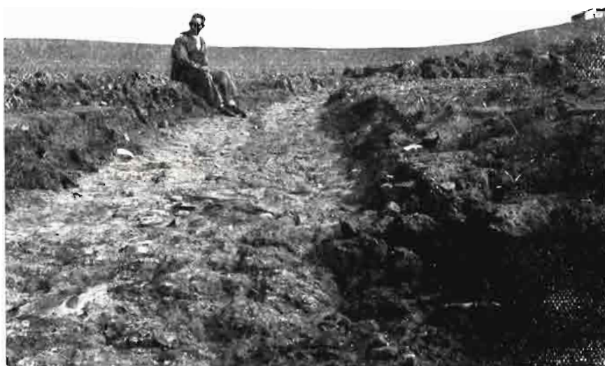
10.—En esta vaguada natural está originándose una cárcava; Cuando se labore de nuevo el terreno, los aperos harán desaparecer su cauce; pero como no se «corrige de modo conveniente», sino que se «rellena un poco», se la borra sólo en apariencia; en las próximas lluvias el agua volverá a concentrarse en esta depresión, que cada año, cada temporal, es más profunda, hasta que se convierta en un obstáculo para el laboreo.
