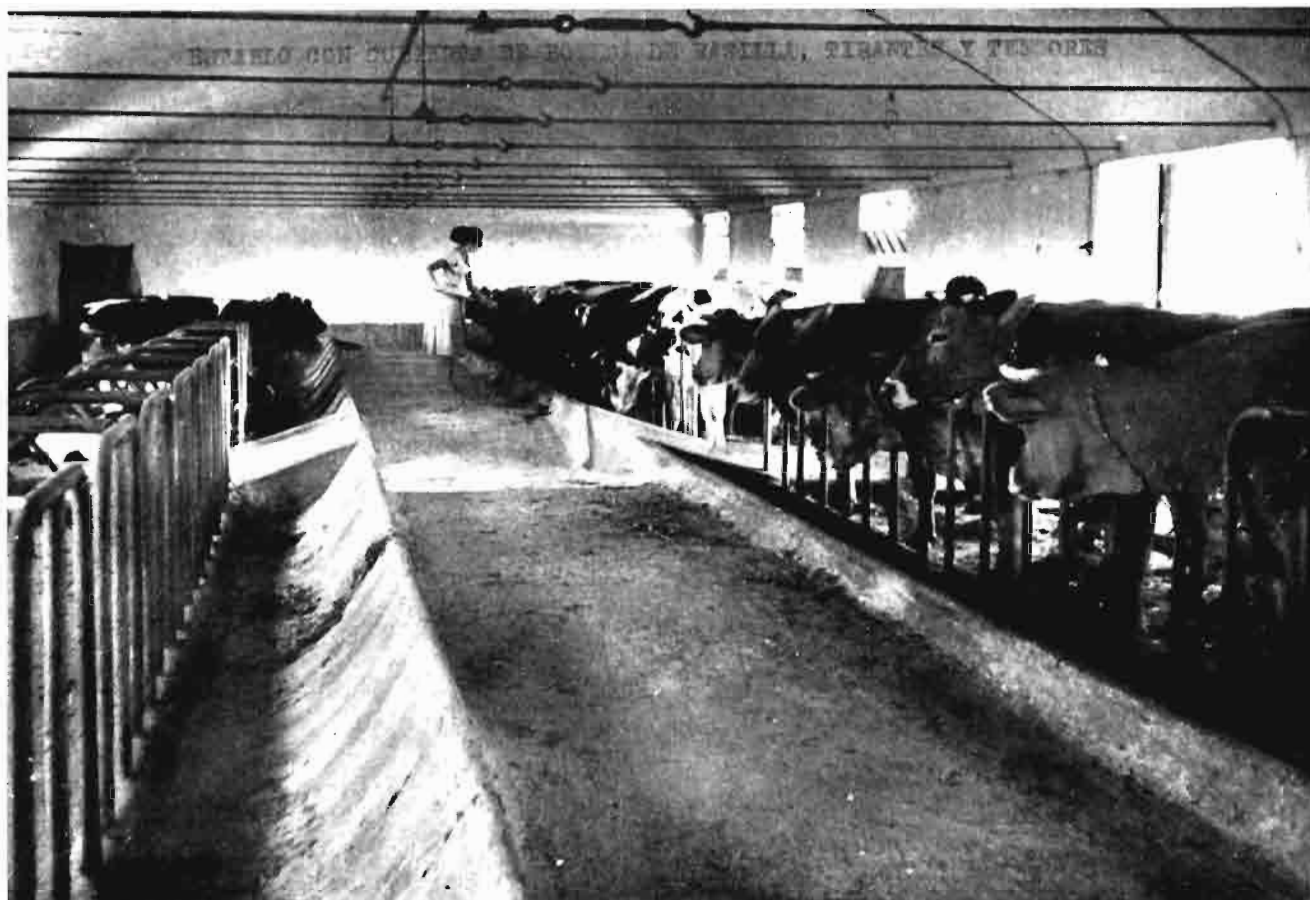
Explotación agraria ejemplar «La Dehesilla» (Palencia). Establo con cubierta de bóveda de rasilla, tirantes y tensores.
