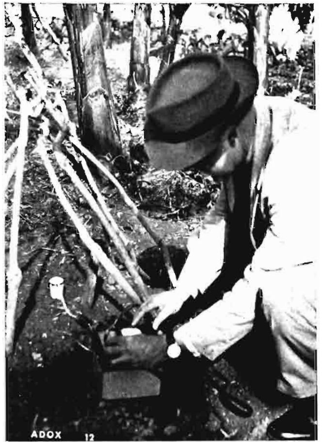
Midiendo la humedad a cuatro profundidades en una huerta de platanera.
