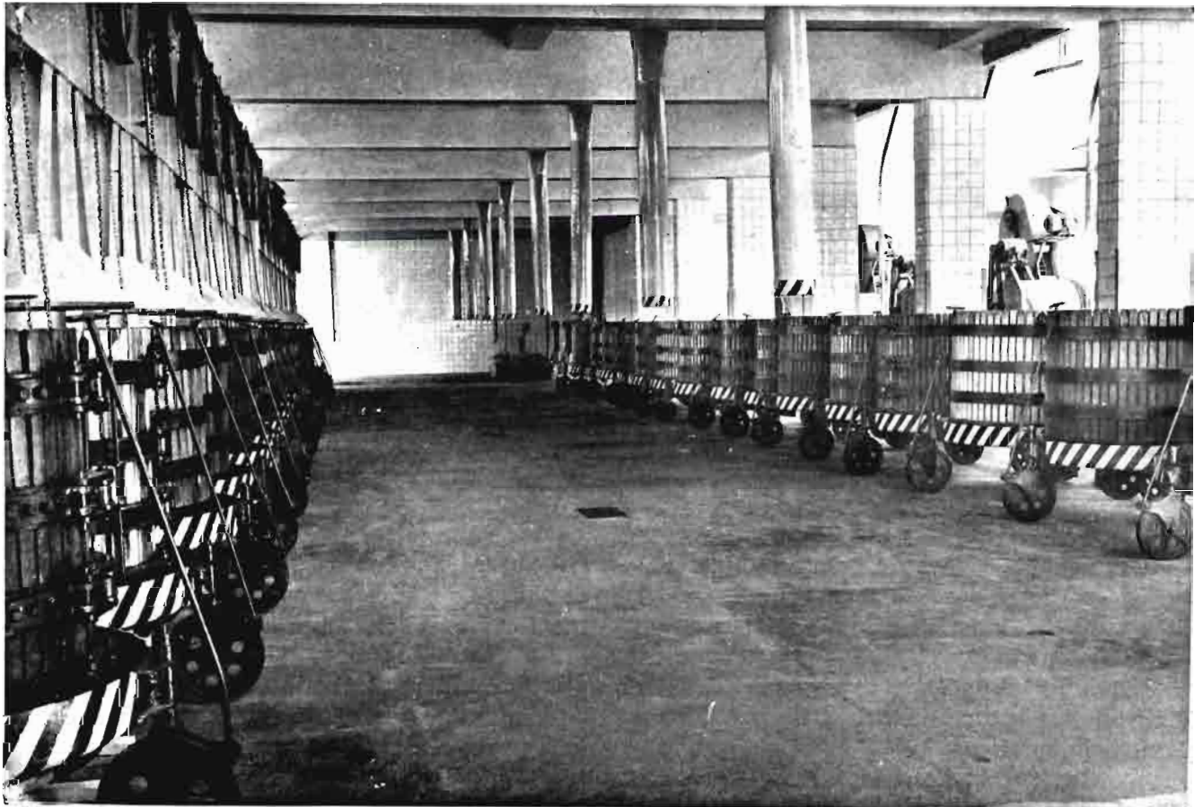
5.—Sala de prensas hidráulicas.
