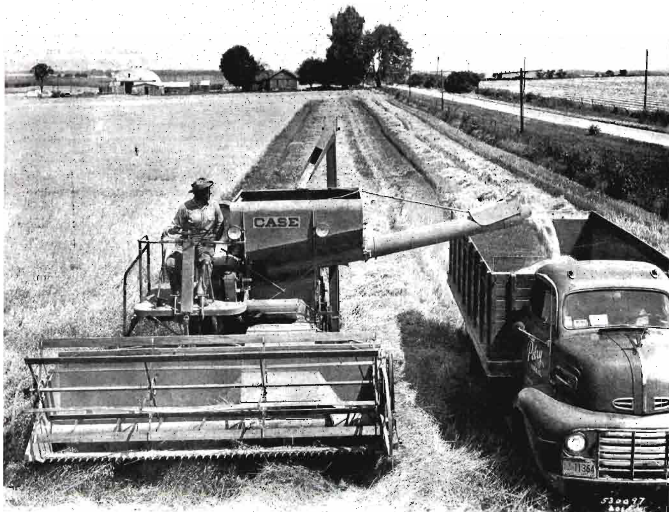
La cosechadora es máquina de amortización lenta si se encierra en su finca y sólo trabaja al año una corta temporada. seguir la recolección de Sur a Norte, con un itinerario bien organizado, significa recoger barato muchas cosechas y almacenarlas en el acto sin desperdiciar grano.
