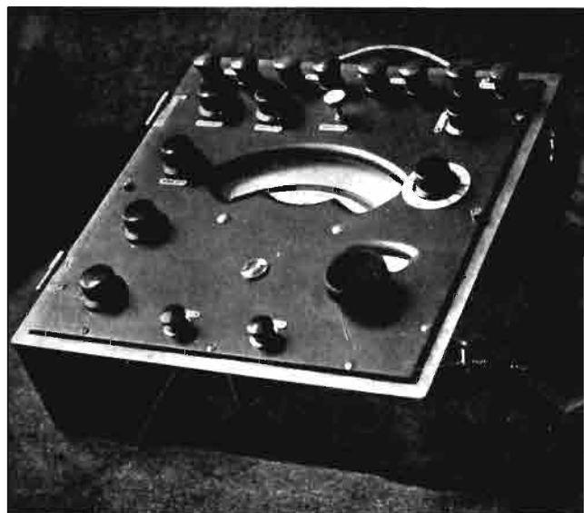
Aparato del Profesor Di Gleria para determinar en el campo el grado de alcalinidad de los suelos.
