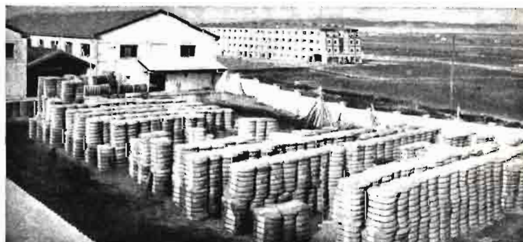
Vista parcial de la importante instalación.
