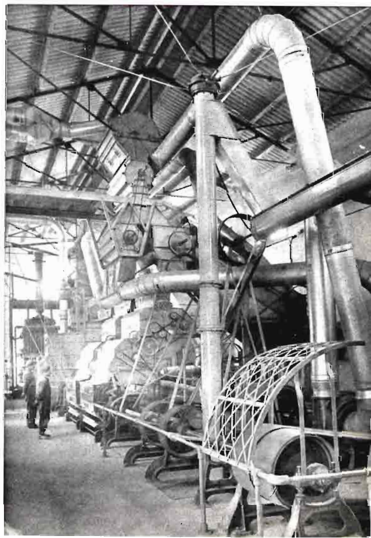
Vista de conjunto de la instalación de dicha factoría.
