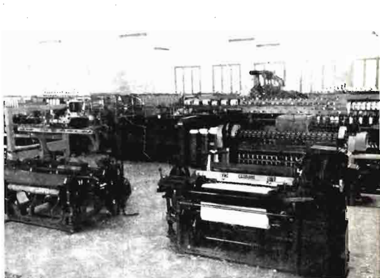
Moderna instalación del Laboratorio Textil en la Factoría de Tabladilla (1931).
