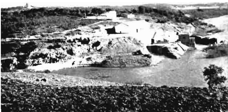
Vista general de la central eléctrica.
