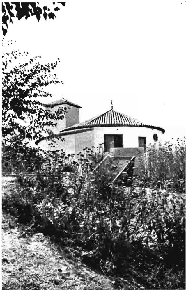
Caseta de transformación y motores del Grupo Sindical de Colonización de Talavera la Vieja (Cáceres) (dos transformadores con 15 KVA y cinco motores con 415 C. V.).
