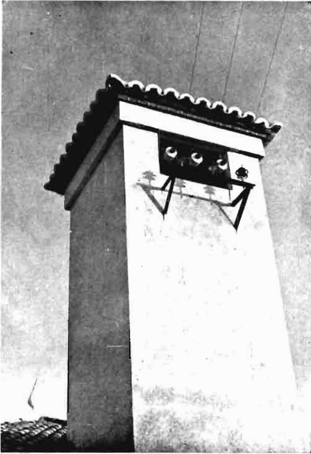
Llegada de la línea de alta a la captación.
