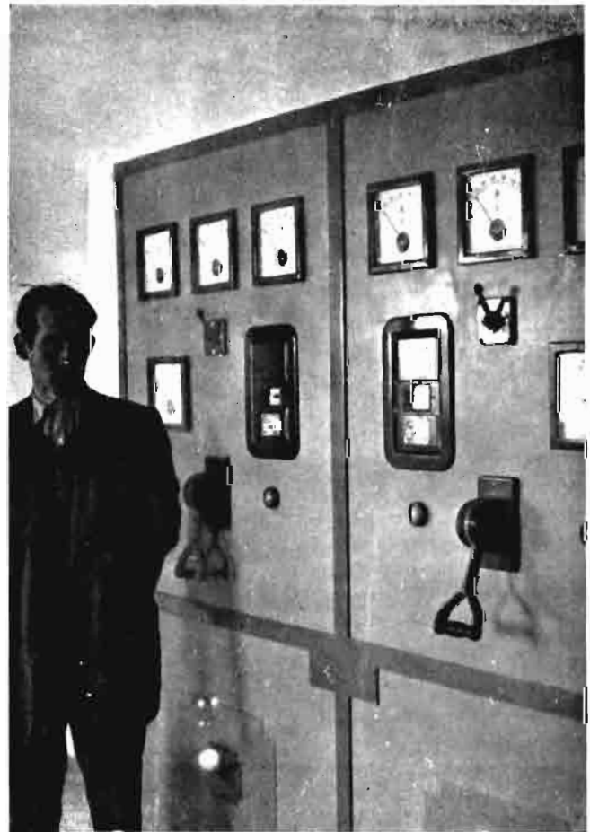
Cuadros de transformador.
