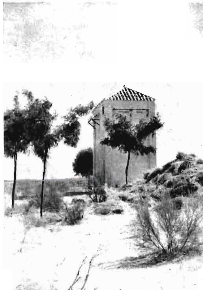
Electrificación para trillas y servicios secundarios en la provincia de Madrid (transformadores de 50 y 5 KVA y motores de 50 y 3 C. V.).
