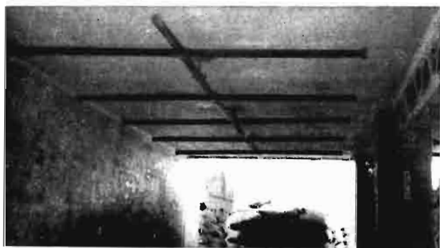
Detalle de la instalación de tubos de entrada de gas
