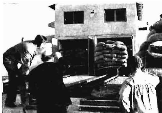
Sacando las vagonetas de la cámara.
