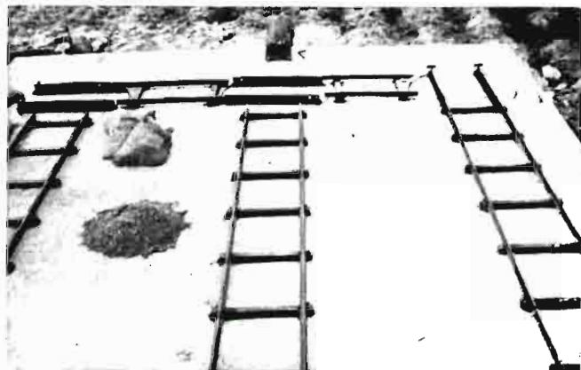
Detalle de las vías con las plataformas giratorias en sus extremos.
