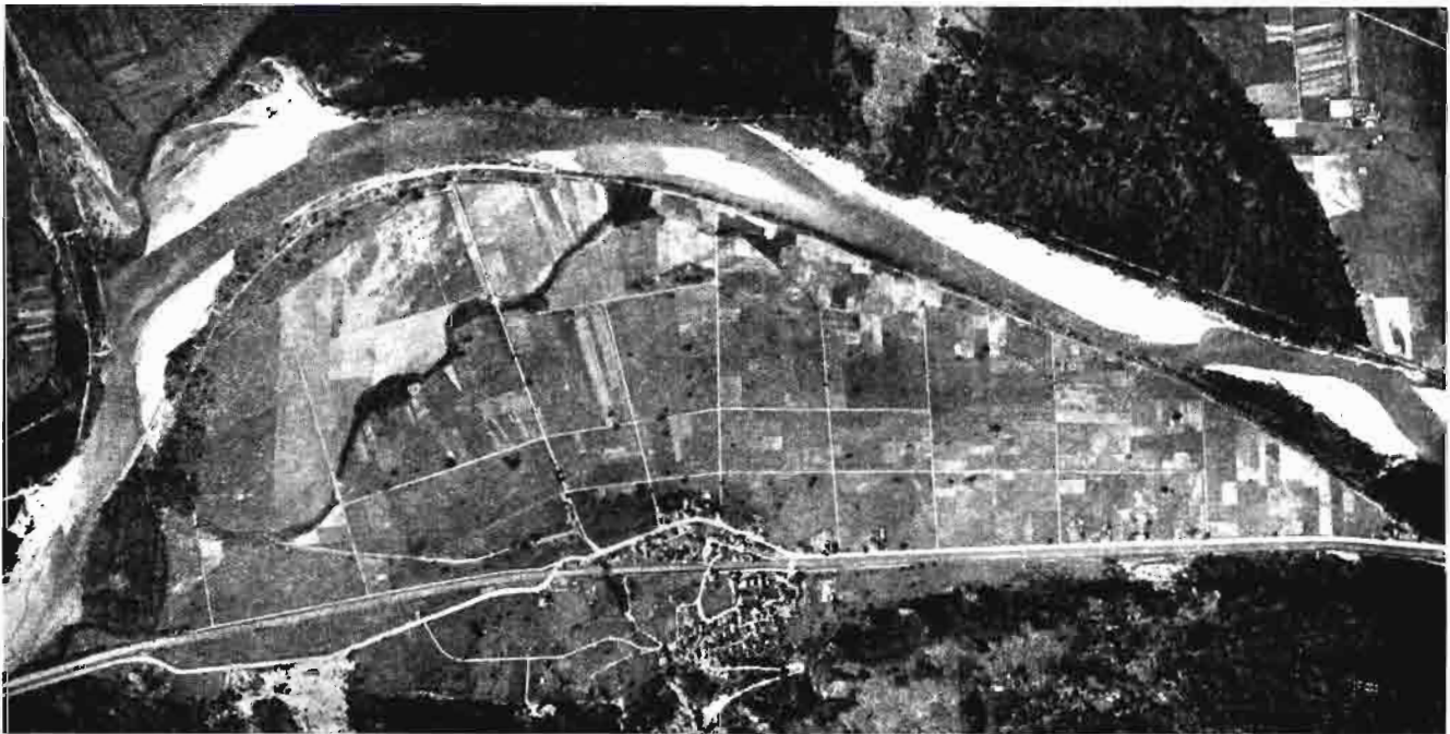
Cresciano (Suiza). Vista aérea antes del saneamiento y de la concentración parcelaria de los terrenos.
