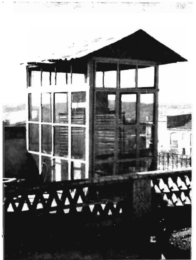
Instalación que funciona en la Estación Enológica de Villafranca del Panadés para desulfitar mostos, de cuya fermentación se aprovecha el gas carbónico.
