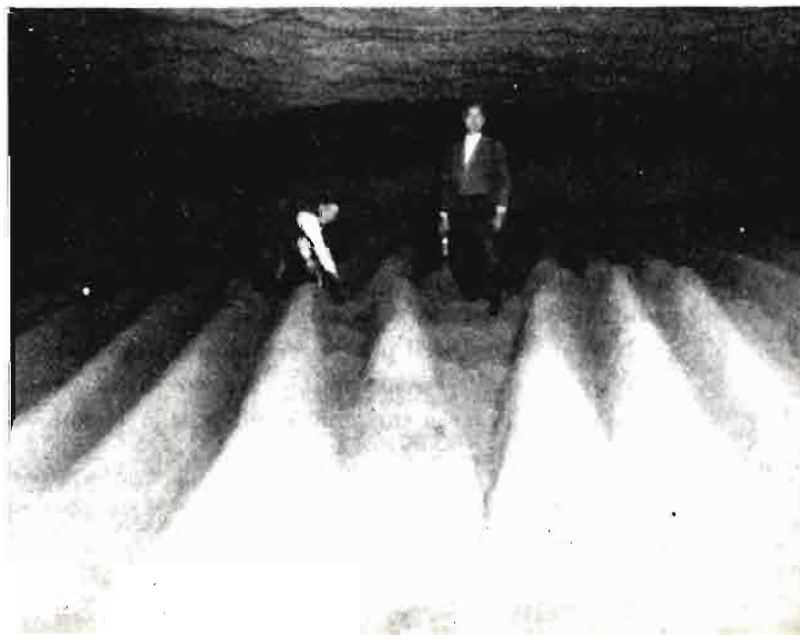
Operación de revoco de los caballones.
