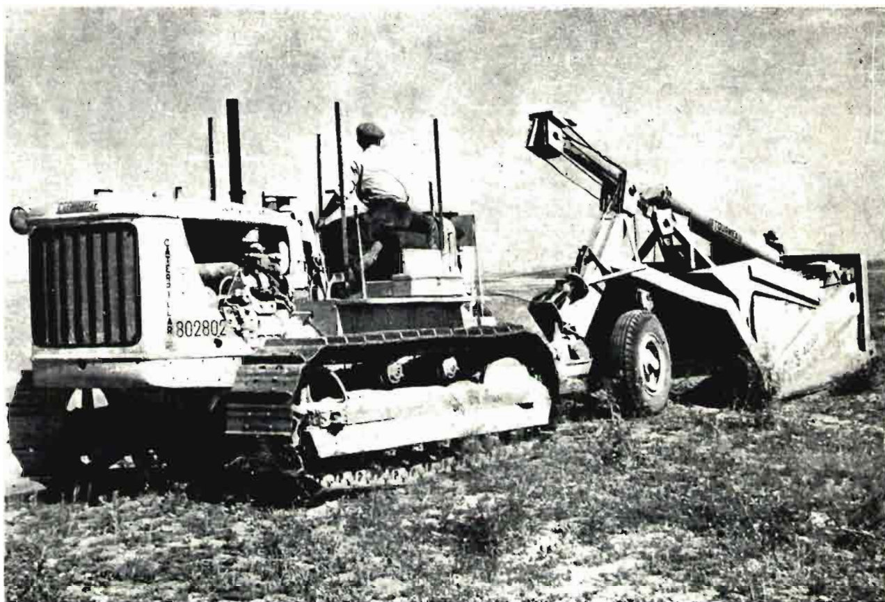
Un equipo de nivelación trabajando.
