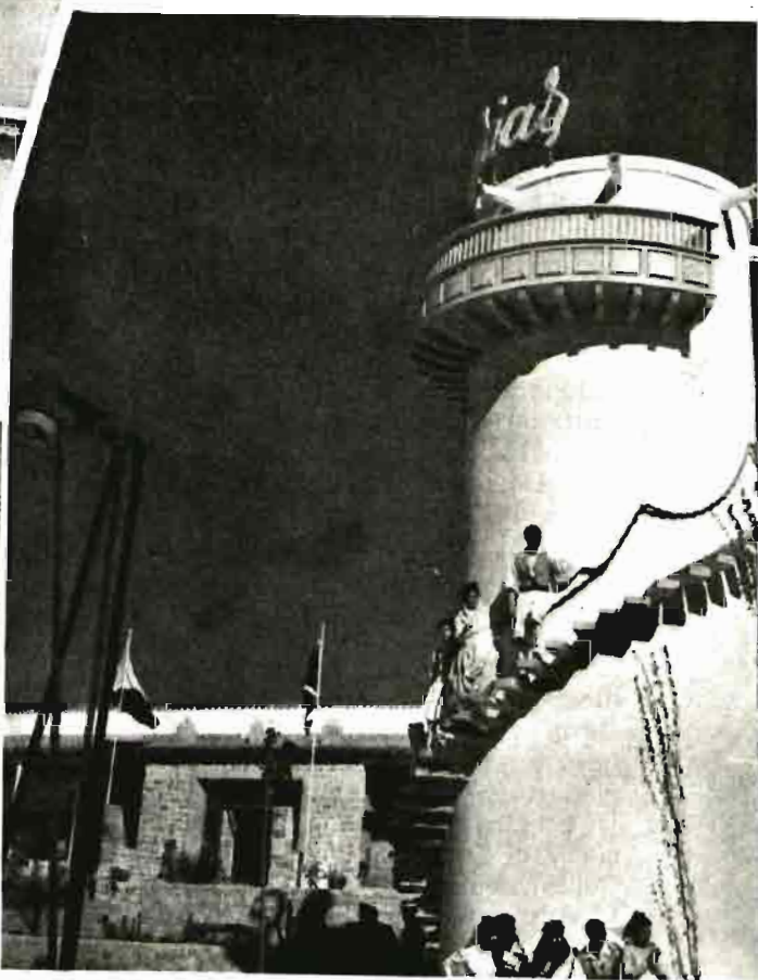
La instalación de Cañar.
