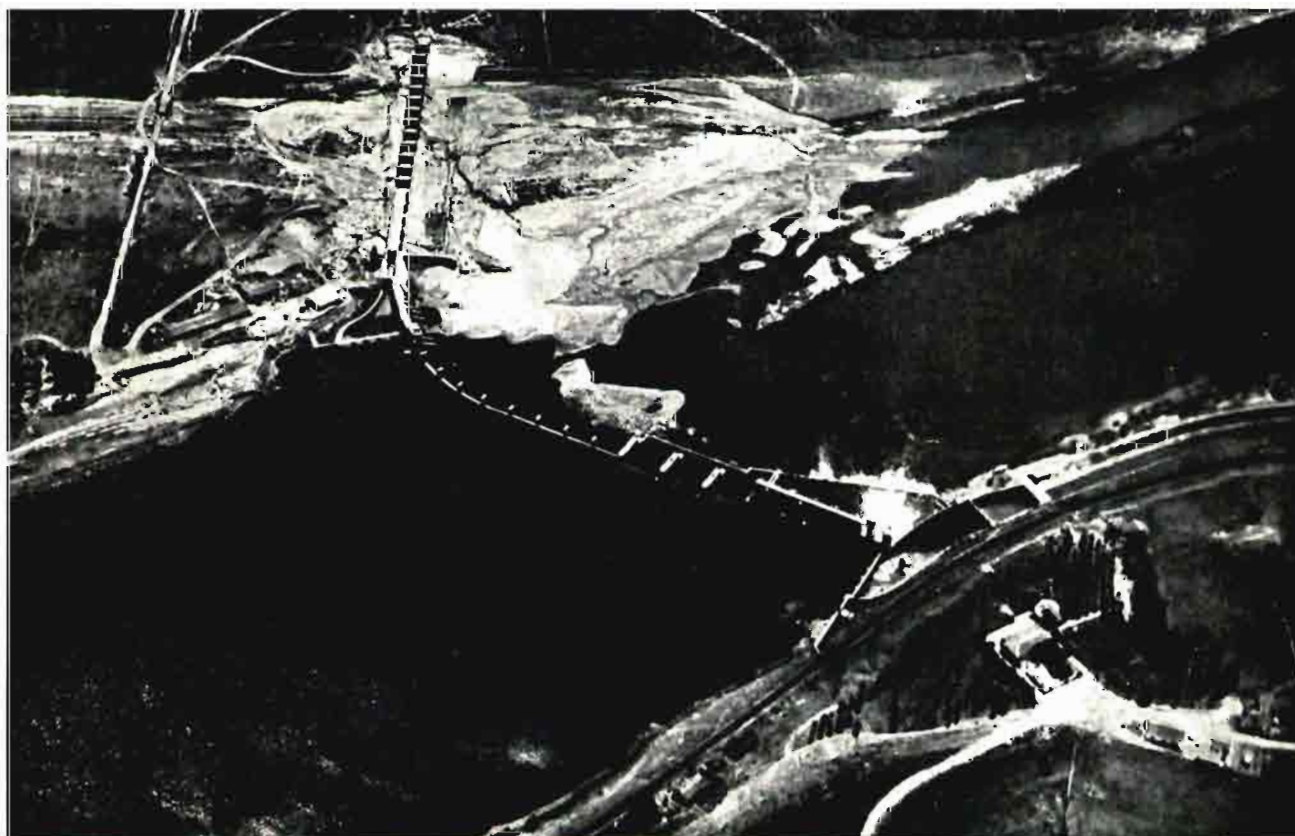
La presa de derivación de Montijo. Al fondo, el arranque del Canal de Lobón.
