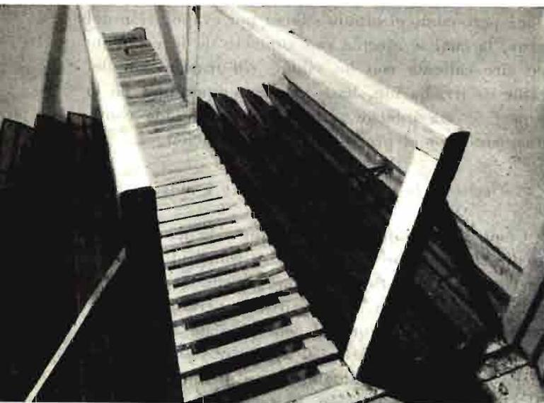
Interior de un secadero, donde se ve, en primer plano, el pasillo que lo atraviesa para la distribución del lúpulo, como asimismo la disposición de las bandejas volteables.
