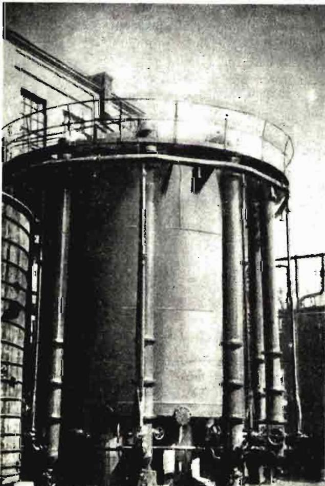
Multiplicador de levaduras con capacidad para 225 m.<sup>3</sup>, de I. G. Farbenfabrik, en la planta de Bitterfeld, cerca de Leipzig.
