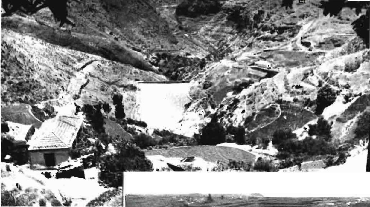
Presas de la Heredad de Arucas, en B. Antona. Lago de 18 metros de altura, el canal es de 30 metros, almacena para 1.000 azudes. No tiene agua aún por falta de medios.
