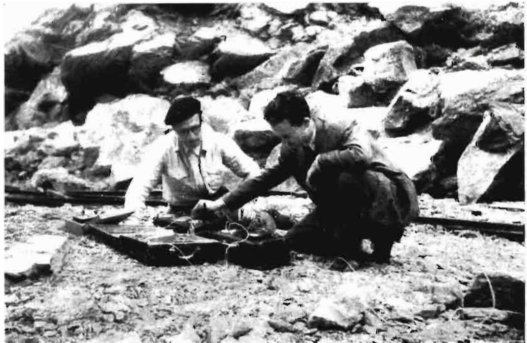
Prospección hasta 40 metros de profundidad, en Galenda (Zamora), con un equipo ligero.
