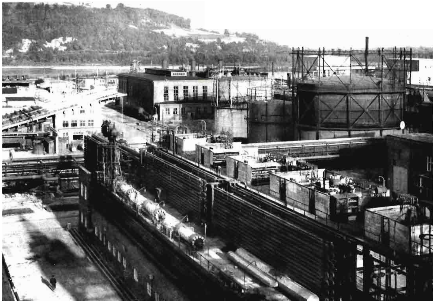
Vista panorámica de la fábrica de Linz (Austria), donde se produce el nitrato amónico rebajado (comercialmente nitramonca).
