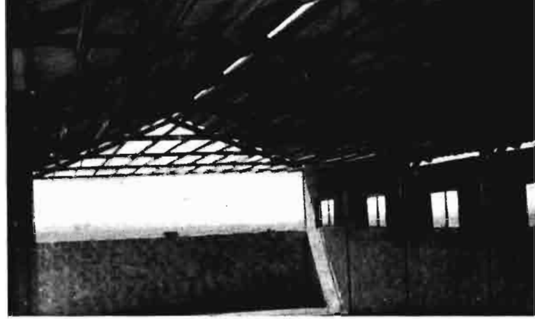
Estructura de los barracones para alojar provisionalmente a los colonos durante las obras de construcción de su definitivo alojamiento.
