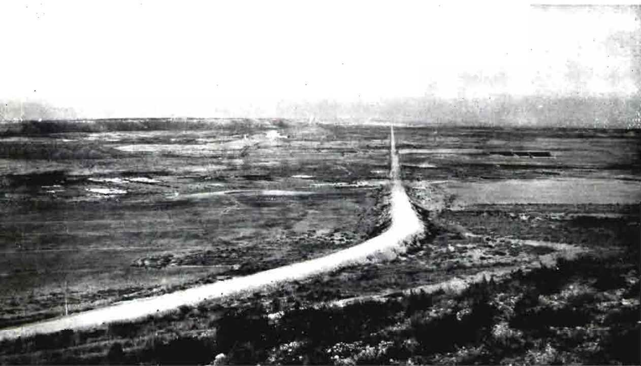
Carretera de Valmañá a Almacellas, en la zona del Canal de Aragón y Cataluña, construida por el I. N. C.
