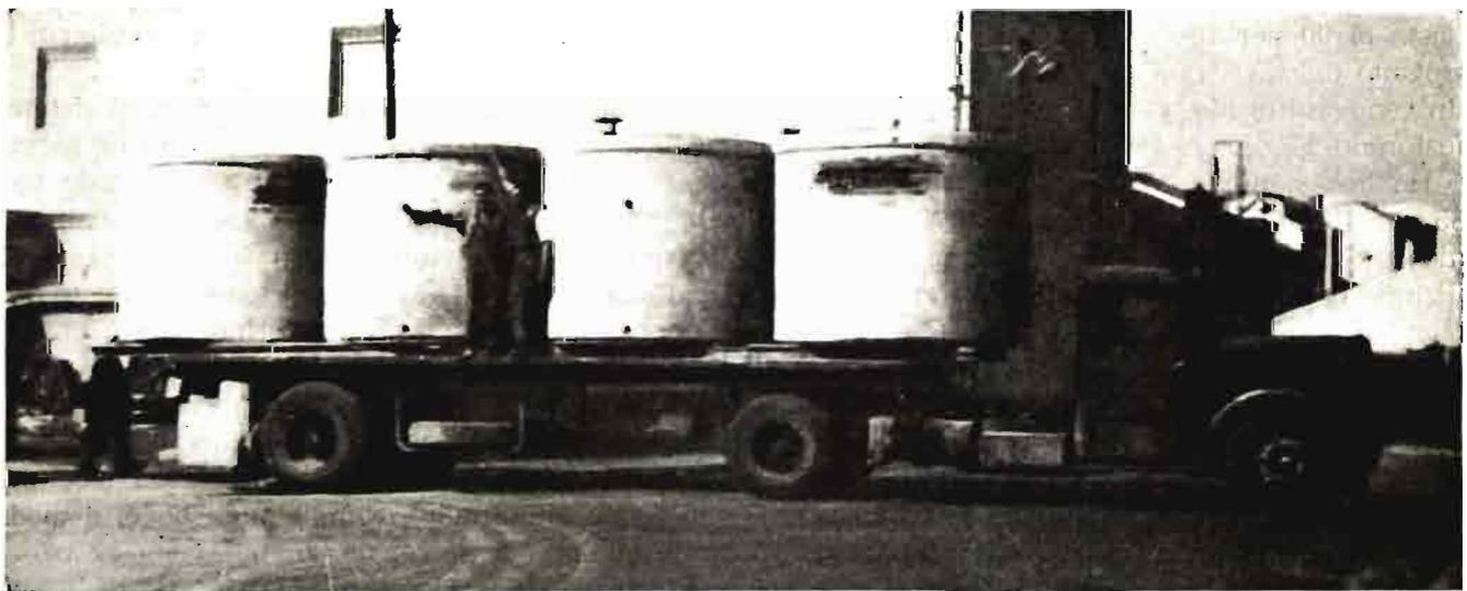
Tinos de hormigón armado prefabricados son conducidos al lugar de su emplazamiento
