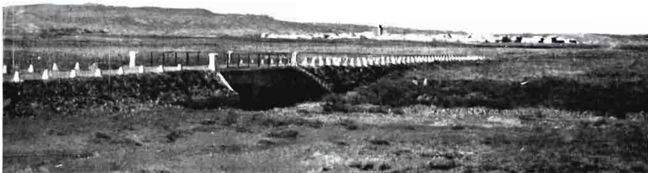
Carretera y puente de acceso a la Zona de La Violada. Al fondo, el nuevo pueblo de Ontinar del Salz (Zaragoza).
