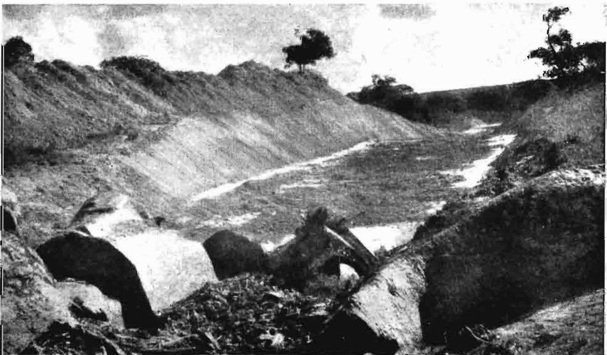
Explanación del ferrocarril Mtwara y Mikiudani.
