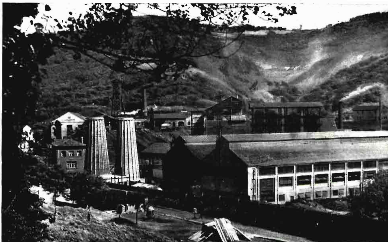
Vista parcial de la Sala de Compresores para fabricación de amoniaco, en la fábrica de Vega-La Felguera (Oviedo). (Sociedad Ibérica del Nitrógeno.)
