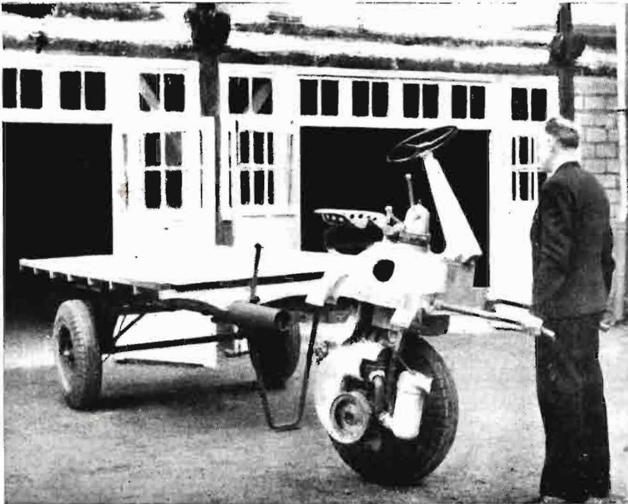
*El caballo de acero de SCAM alcanza el grado más alto de simplificación para la tracción mecánica: una sola rueda constituye el bloque motriz y directriz, que se adosa con gran facilidad a los distintos aperos.*
