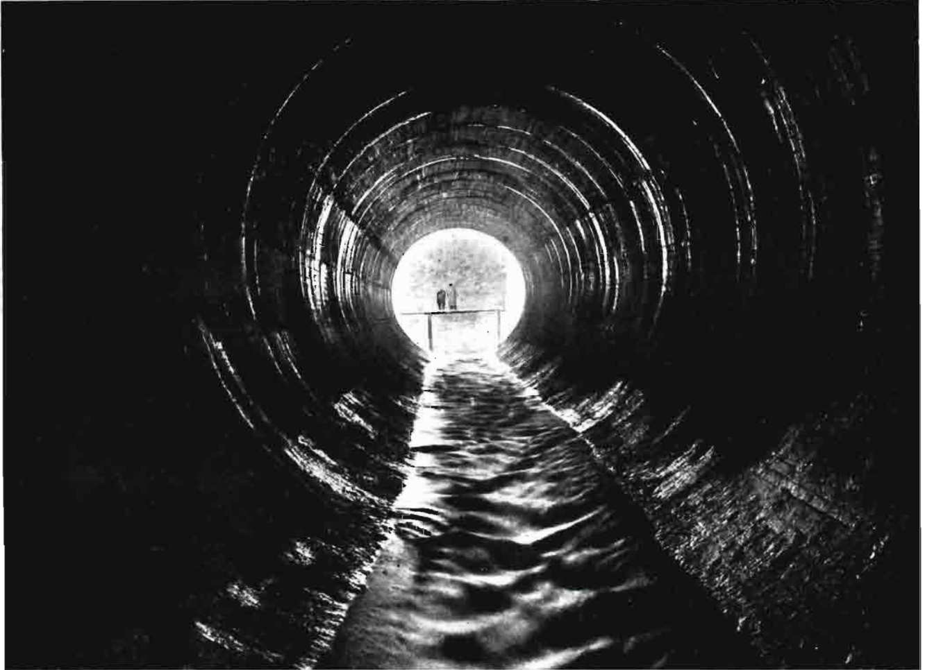
Túnel de desviación de aguas.
