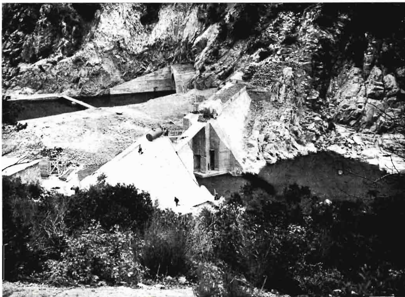
La ataguía y entrada al túnel de desviación.
