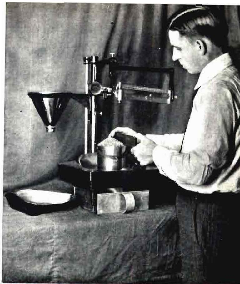
Fig. 5.—Balanza especial para pesar trigos.
