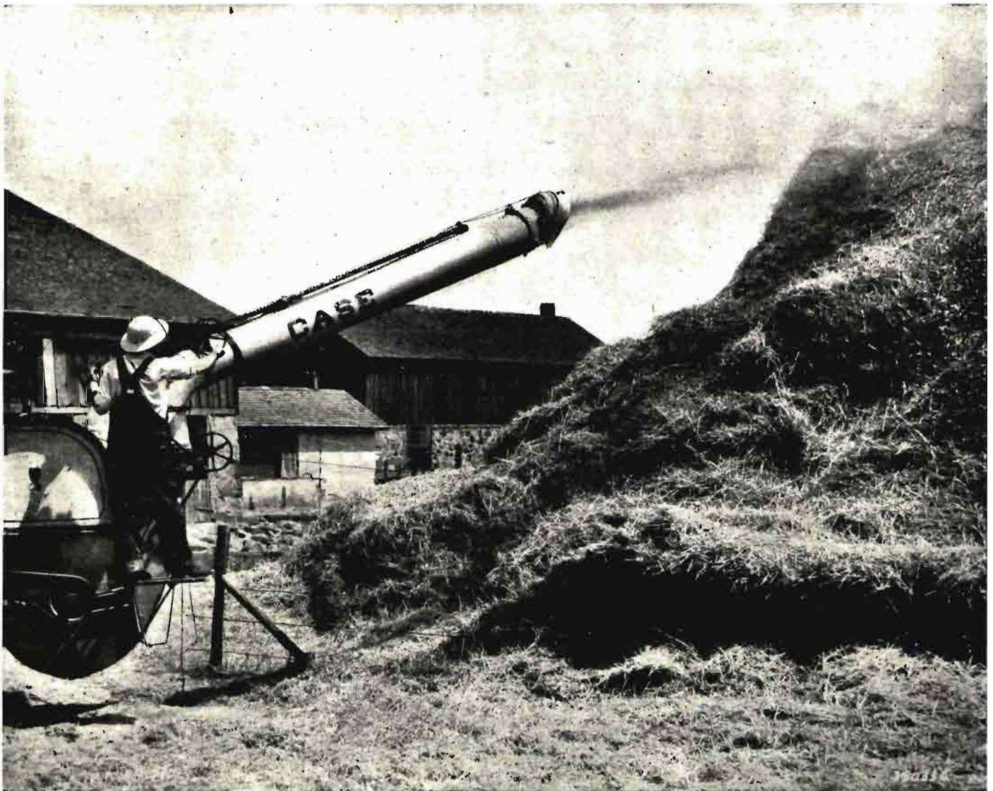
*El lanzapajas es un accesorio utilísimo, pero consume mucha potencia, exactamente el 42 por 100 de la necesaria para mover la trilladora en vacío.*
