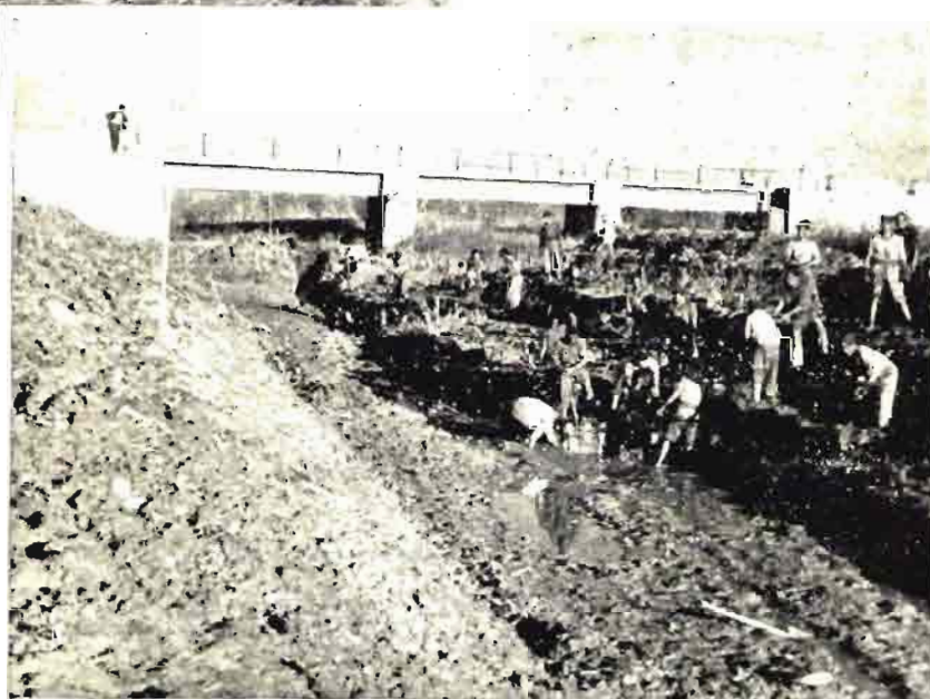
← OBRAS DE TIERRA EN UNA ZONA REGABLE. -- Rectificación del cauce y limpieza de un gran colector de la red de evacuación o desagüe. ↓
