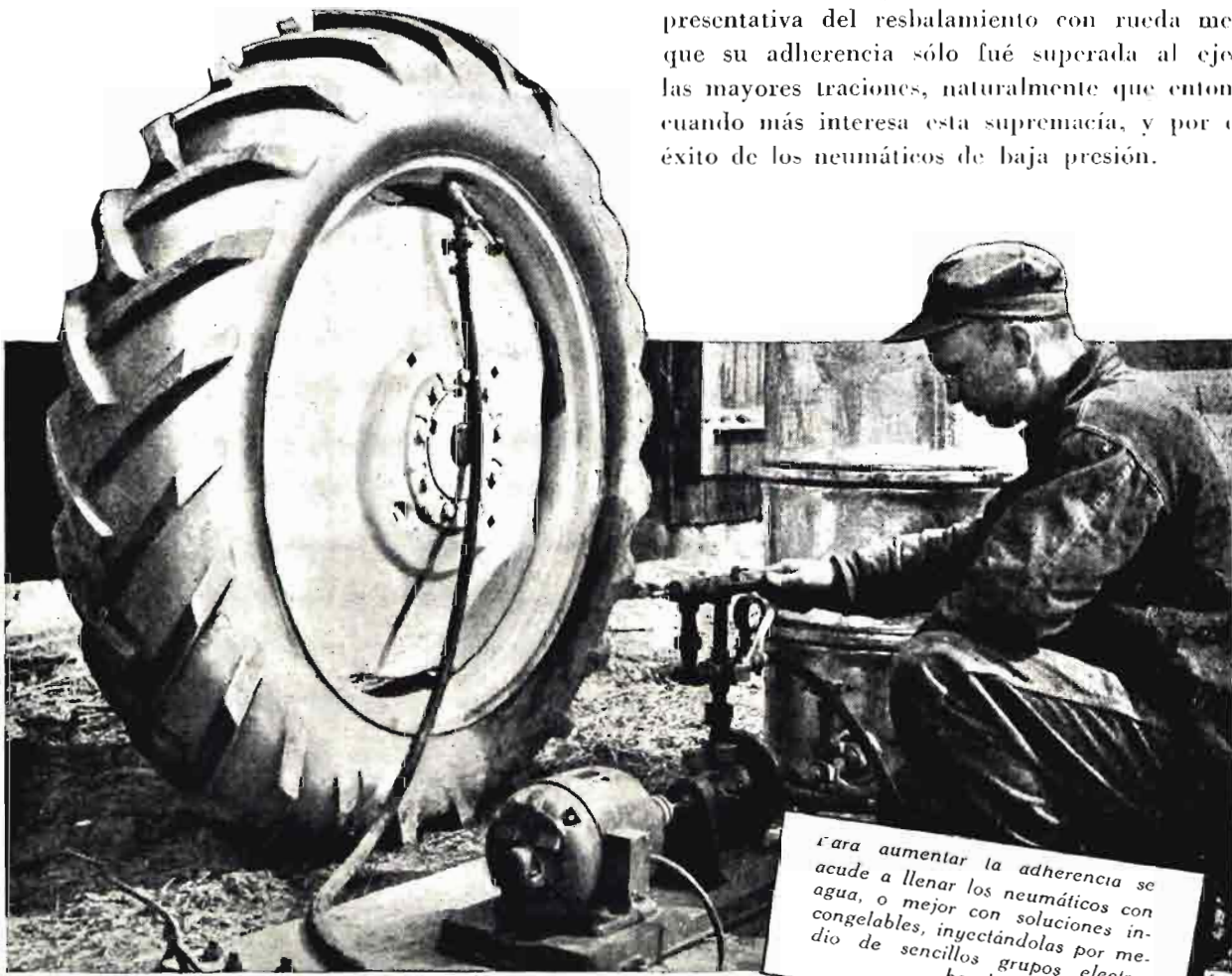
Quando se desea llenar el neumático por completo de líquido, es preciso extraer el aire que queda acumulado sobre la válvula, empleando un sistema de aguja como el representado esquemáticamente.
