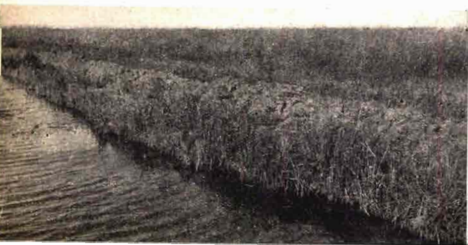
Foto 3.—Dique recién construido.
