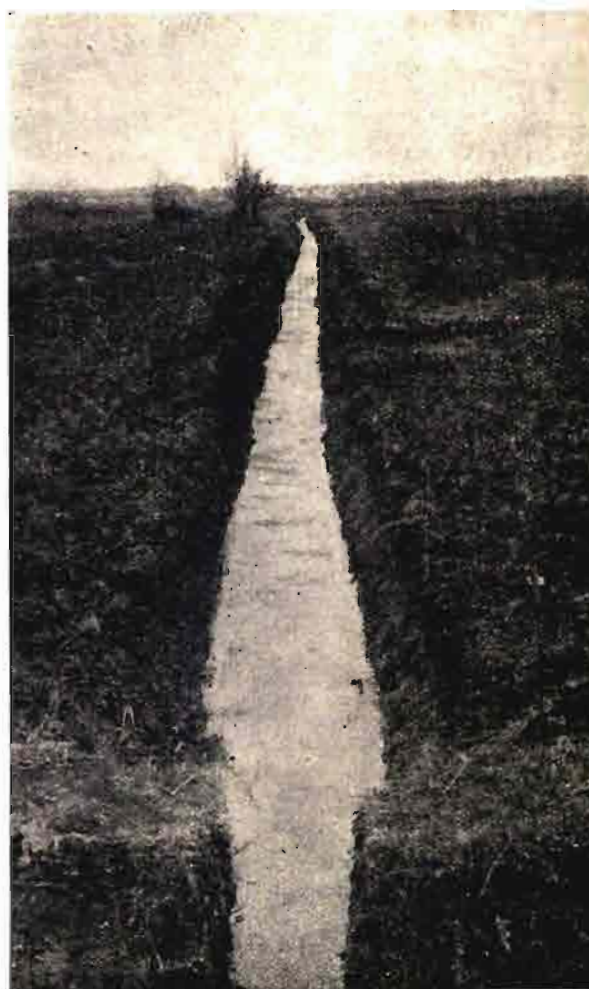
Foto 5.—Canal de drenaje recién abierto.
