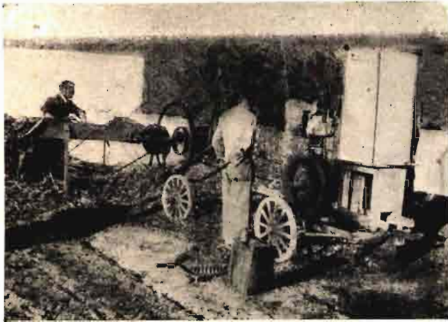
Cortando caña de panizo para ensilarla en sencillísimos silos hechos en tierra y revestidos. El cortaforrajes es accionado por un motor de gasolina, portátil.
