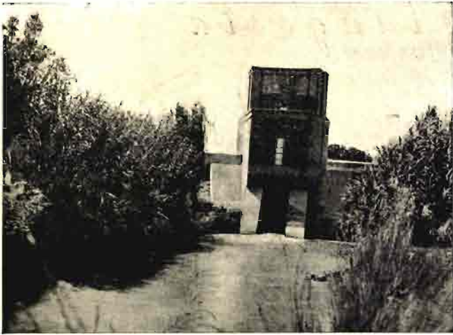
Compuerta de la Acequia de Cullera (Júcar).
