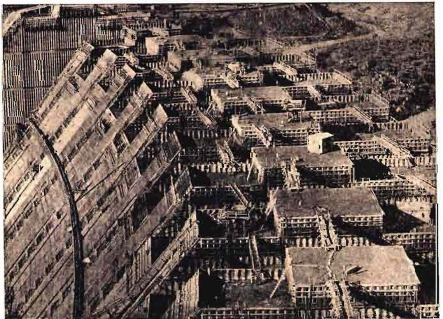
Figura 1.—El inmenso frente de la presa de Shasta, en California, durante su construcción, con sus moldes de madera, en los que se vertieron más de cuatro millones y medio de metros cúbicos de hormigón. La cascada que caerá sobre ella tendrá tres veces la altura de las Cataratas del Niágara.
