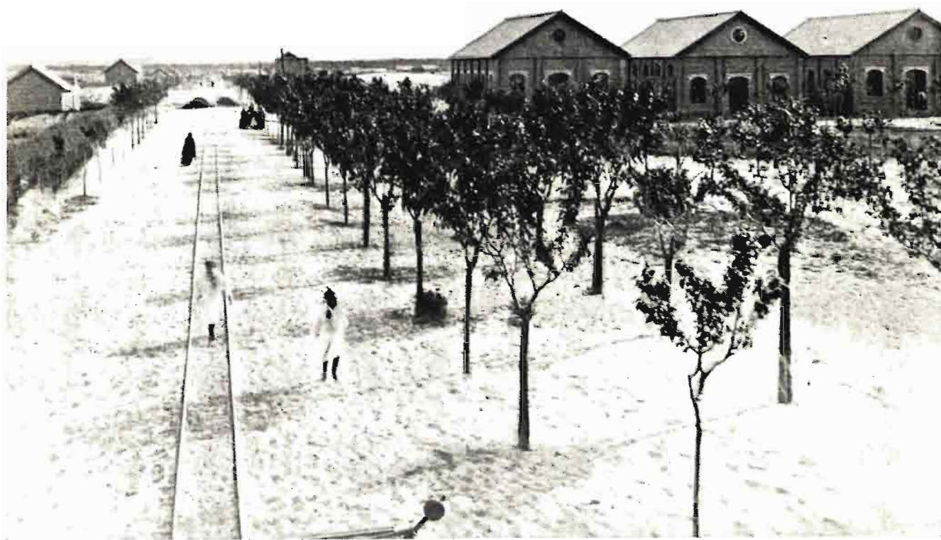
Edificios comunales de la colonia de La Algaida
