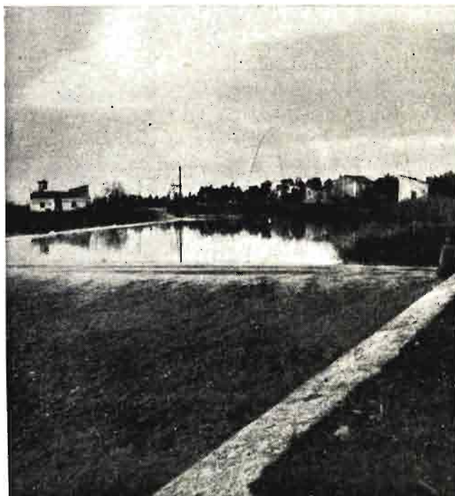
Presa de Cullera
