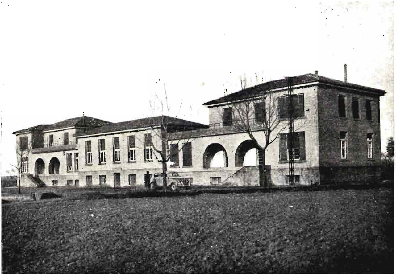
Subestación del I. N. I. A. en Egea de los Caballeros
