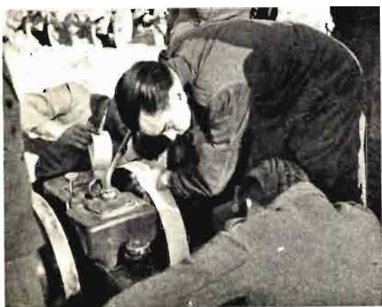
La práctica es inmediata en todas las explicaciones, como, por ejemplo, al señalar sobre el volante los tiempos de las válvulas.
