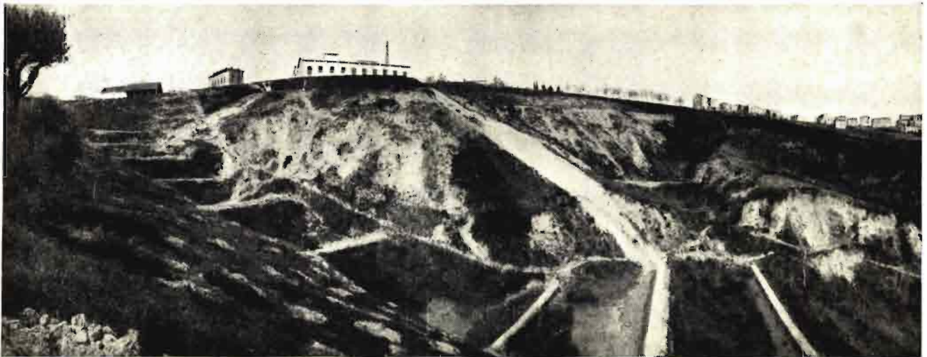
Grabado 6.º—Un aspecto de los alrededores de Offida recién construidas las presas.
