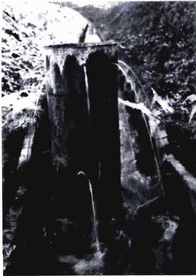
Fig. 5.ª - Cuando se cierran los orificios inferiores, el agua se eleva, formando al salir una fuente con muchos chorros.
