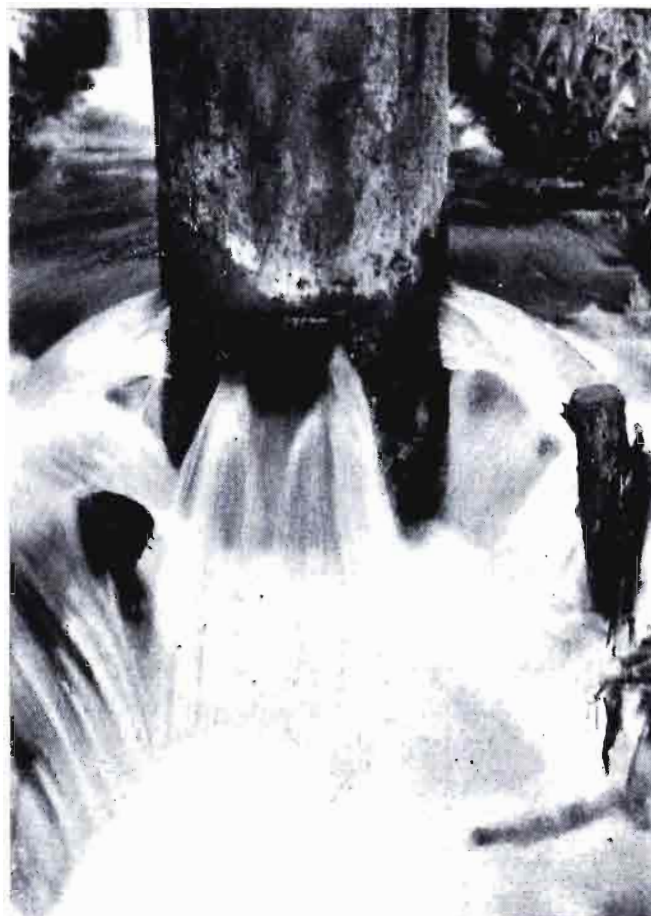
Fig. 4.ª—Detalle de uno de los tubos más caudalosos.
