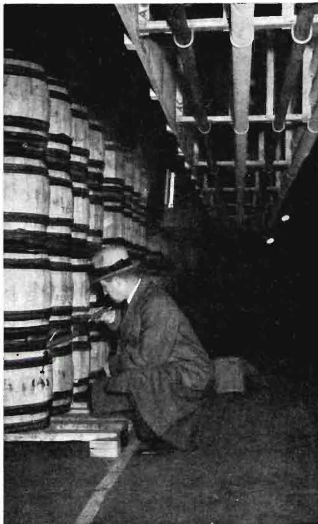
COLOCACION DE LOS TERMOMETROS. —En esta fotografía se muestra cómo se colocan los termómetros en los barriles, abriendo un barreno en la parte superior del costado del barril en puntos como el (A), introduciendo por dicho agujero el termómetro.
