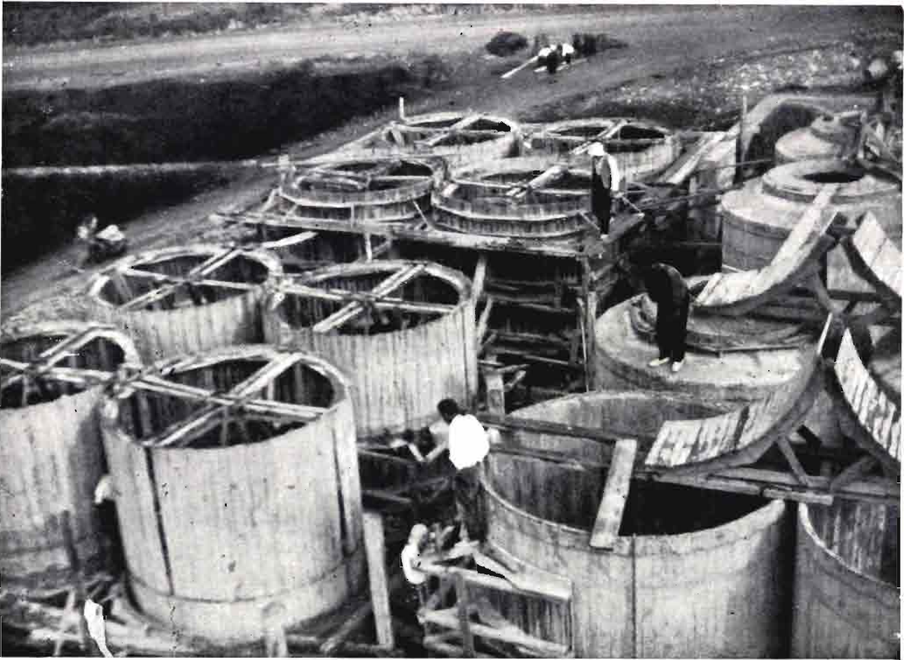
BODEGA COOPERATIVA CIRVONERA, DURANTE LA CONSTRUCCION DE LOS TINOS PARA FERMENTACION. En las bodegas cooperativas españolas se trabaja con métodos racionales de elaboración, pero aún no hay ninguna montada al estilo de gran industria que pueda realizar fermentaciones durante todo el año o en épocas que convengan.
