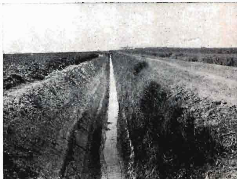
COORDINACION DE LAS REDES DE RIEGO, SANEAMIENTO CAMINOS RURALES.—Zanja secundaria de saneamiento con camino rural entre ella y la acequia secundaria paralela. A la izquierda, terreno conquistado, de tres años con algodón, y derecha, terreno por conquistar en el Bajo Egipto.
