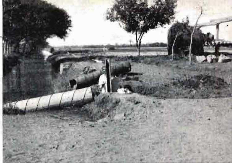
RIEGOS ELEVADOS.—Elevación de agua para el riego en el Alto Egipto, mediante noria y tornillo de Arquímedes.
