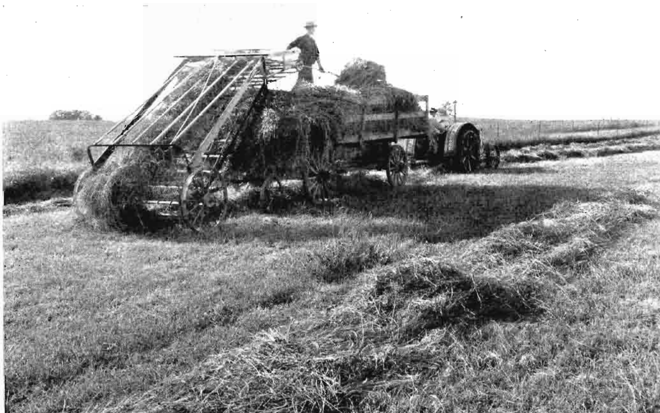
ELEVADOR DE HENO.—Con el cargador de heno, que se adapta a la trasera del carro, sube el heno a la altura conveniente para que el obrero lo distribuya con suma facilidad.
