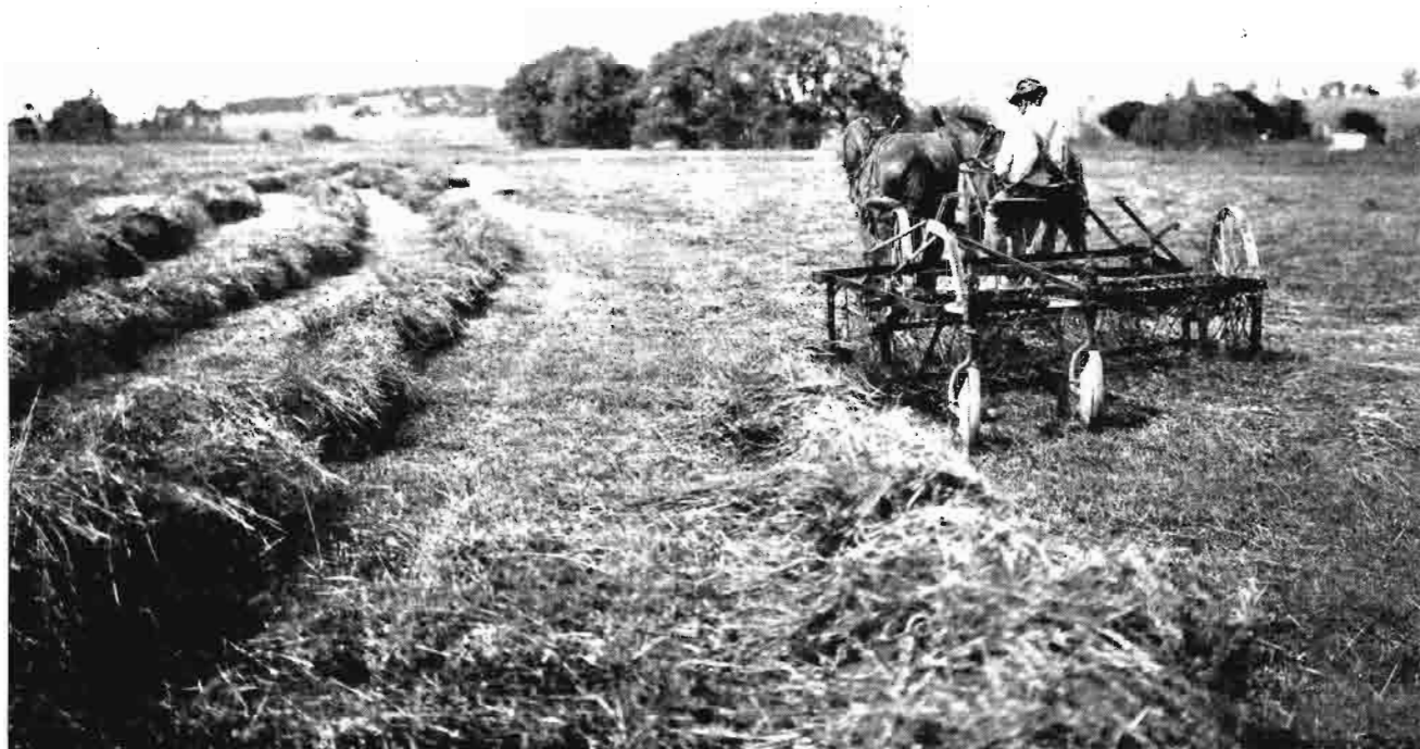
RASTRILLO A DESCARGA LATERAL.—El rastrillo de descarga lateral continua pasa sobre la pradera segada y forma con el forraje seco hileras que después se recogen fácilmente.
