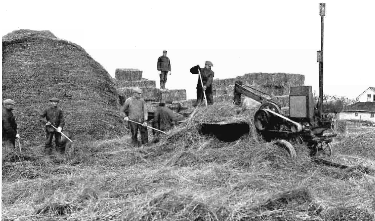
EMPACADORA FIJA.—Las empacadoras mecánicas con motor acoplado directamente quedan instaladas de manera fácil en cualquier lugar sin necesidad de tender y alinear la correa, como hace falta con las de motor independiente.
