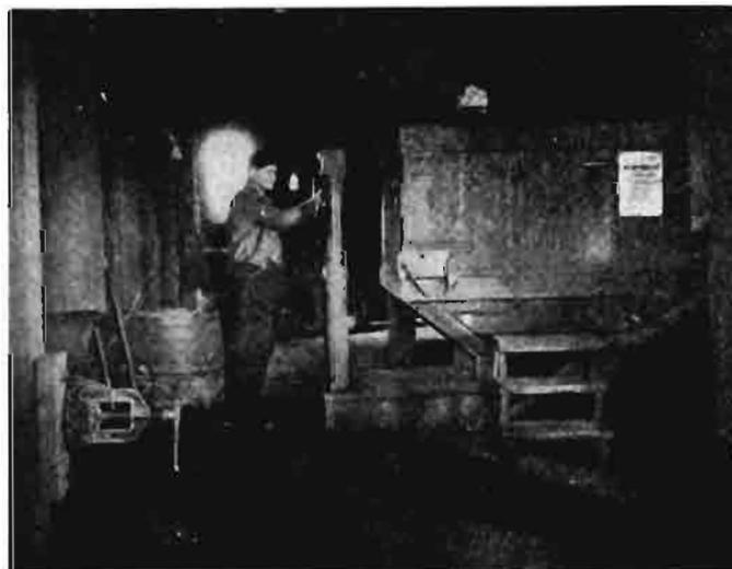
Báscula colocada en el interior del elevador para pesar el trigo sometido a limpieza y el que sale del elevador para cargar los vagones de ferrocarril.
