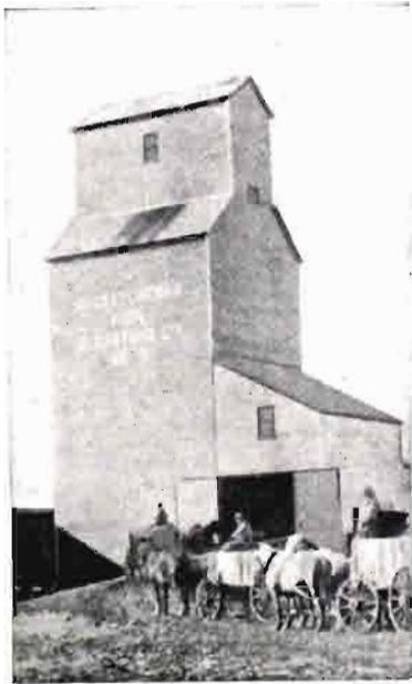
El carro-camión cargado de trigo, entra en el elevador por una rampa de subida.
