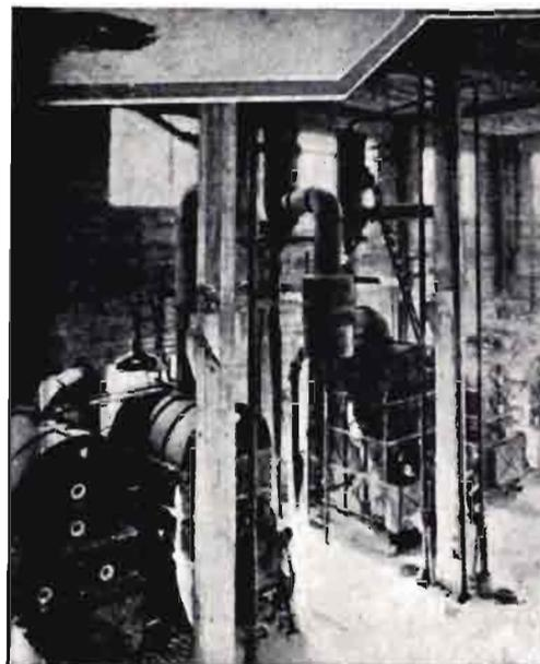
Evaporadores de múltiple efecto en una fábrica de concentración de mostos en California.
