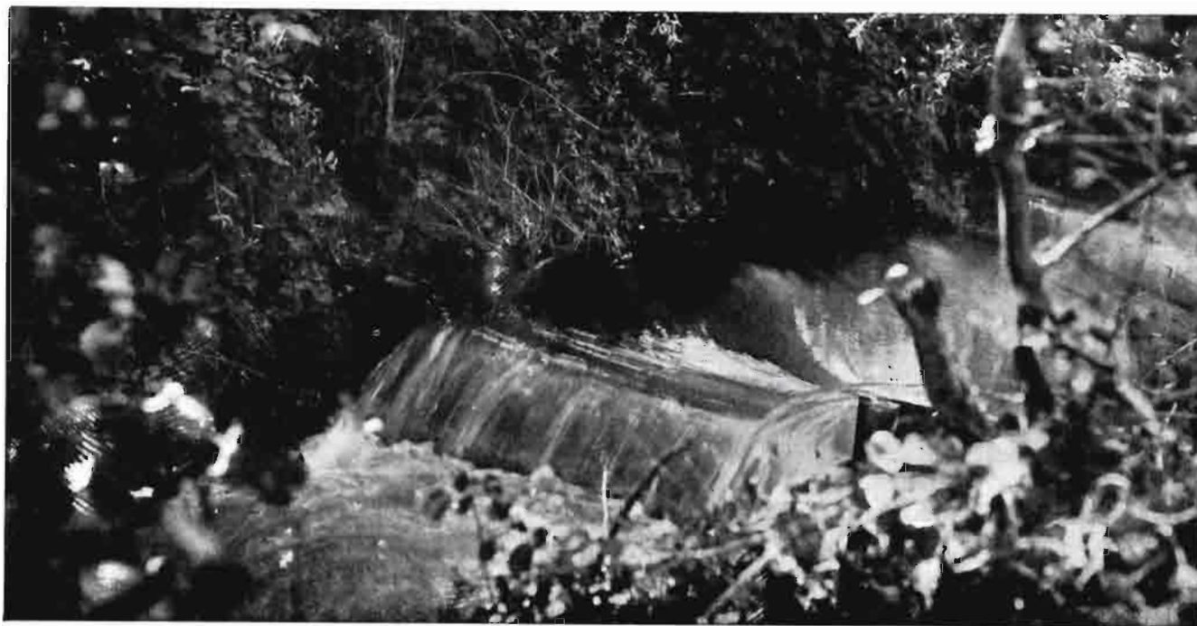
Vertedero libre en pared delgada, para aforo de pequeños caudales. (Foto Servicios Hidráulicos del Duero.)
