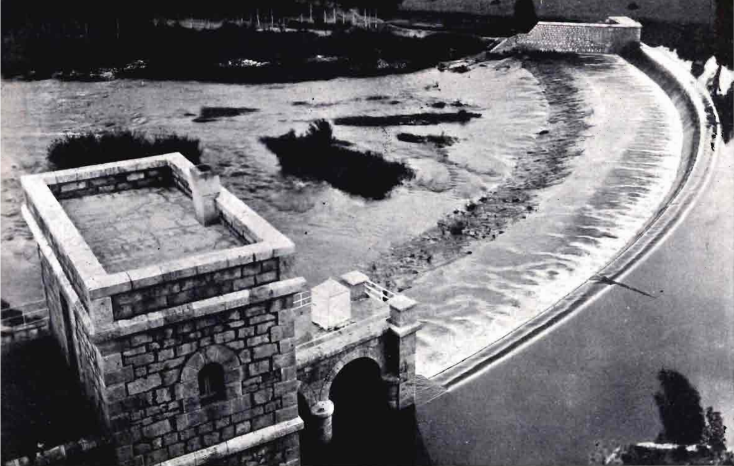
Presa de toma del canal de Guma.
